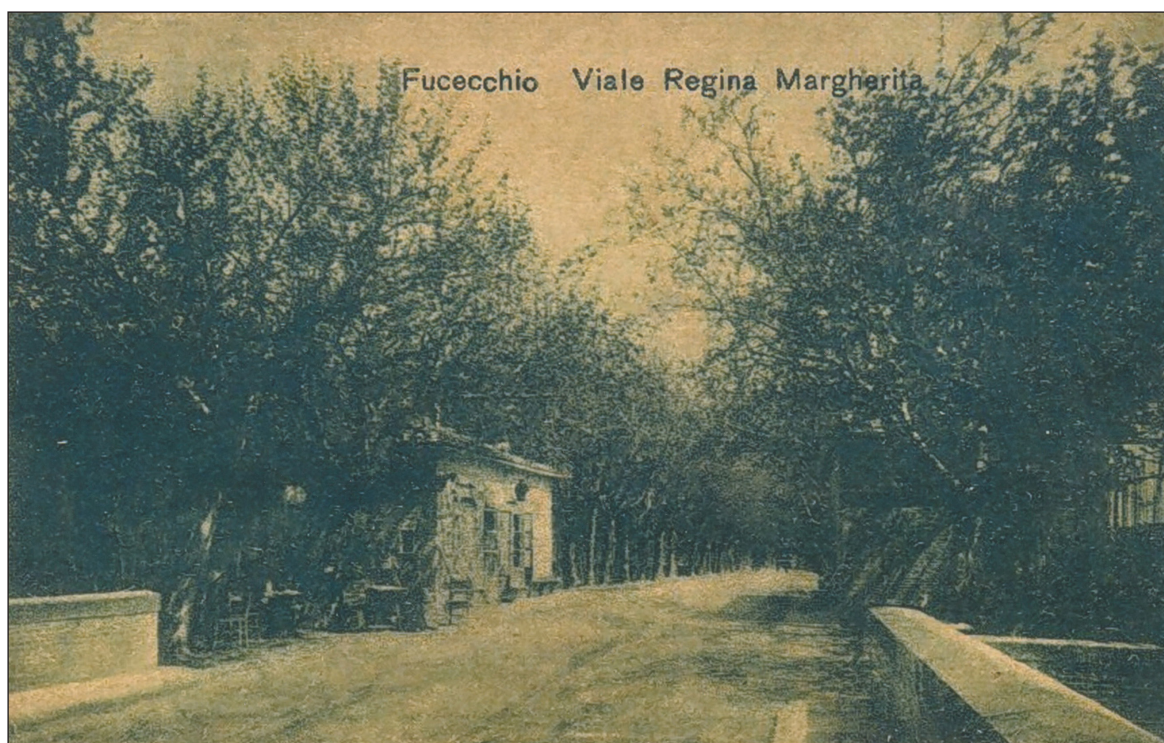
1930 circa, uno dei due casotti, quello posizionato a destra imboccando il ponte, provenendo dall'allora viale Regina Margherita, attuale viale Gramsci.
