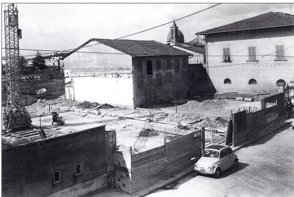
Anni '60 dello scorso secolo, via Roma, l'arena Edison e il cinema realizzato intorno al 1913 dal sig. Candido Mechetti. La foto successiva mostra la stessa area dopo l'intervento di demolizione. (Fonte: Ufficio tecnico del Comune di Fucecchio).
