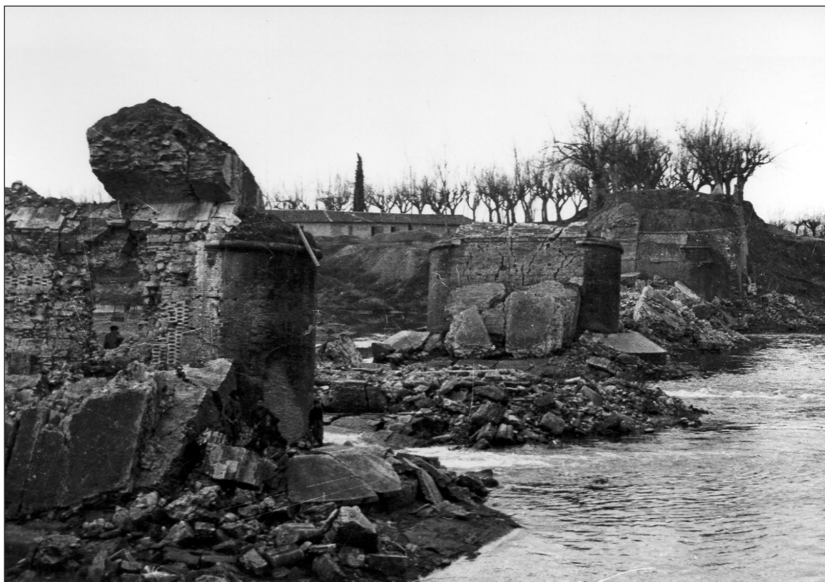
Il ponte come si presentava poco dopo il bombardamento aereo del 2 luglio 1944. ( Da G. Pierozzi, Fucecchio Immagini, ricordi, emozioni, p. 189).
